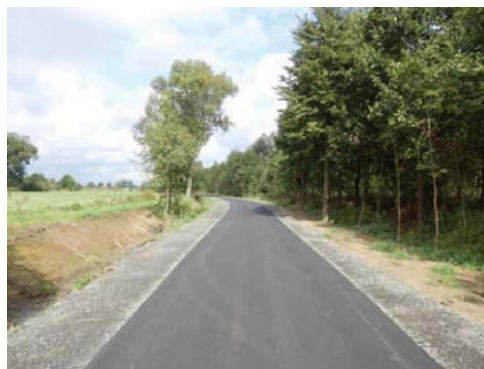
Fot. 2. Droga w Kościelnikach Dolnych
