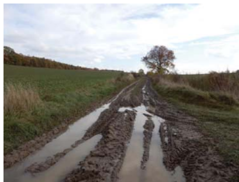
Fot. 22. Droga w Mściszowie wskazana do przebudowy (dz. 3)
