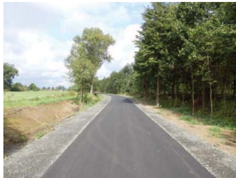
Fot. 10. Droga w Kościelnikach Dolnych
