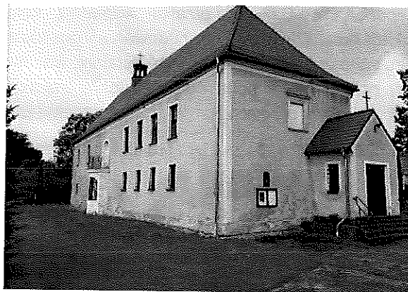
Fotografia 8. Widok na Dwór, ob. kościół filialny pw. Chrystusa Króla w Nawojowie Łużyckim.
