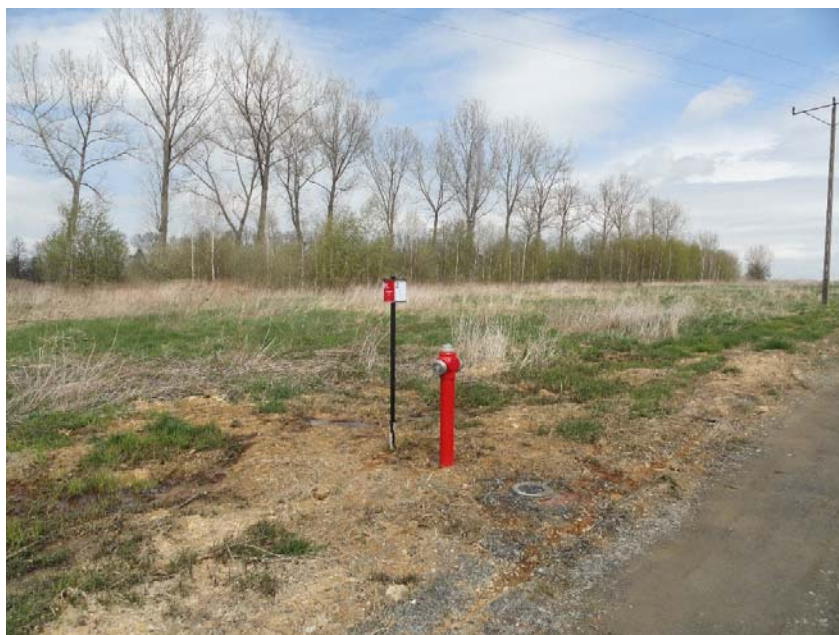
Przebudowa sieci wodociągowej w Kościelnikach Dolnych (etap I);
